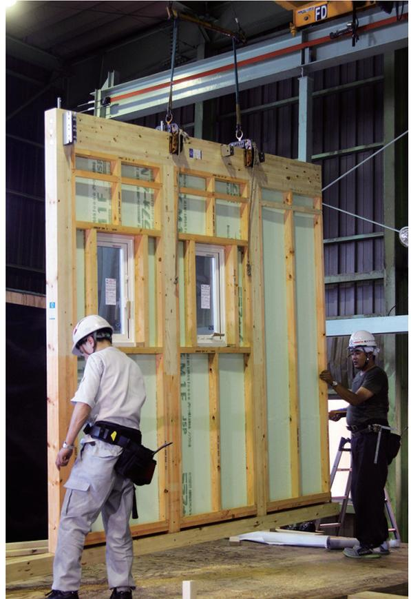
「ハイブリットユニット工法」は、木造軸組在来工法でありながら枠組み工法を取り入れて、サッシや断熱材を組み込んだ大型パネルを工場生産する工法。最短一日で、屋根ルーフィング・サッシ取り付け・断熱施工・間仕切り壁下地まで施工完了できる。6月に行った実験棟の上棟では200名の見学者があった。
