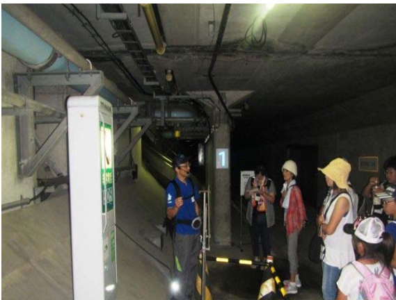
【アクアトンネル：緊急避難通路探検】
