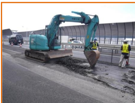
【アスファルト舗装はぎ取り状況※】
