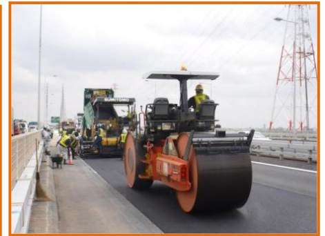
【アスファルト舗装施工状況※】
