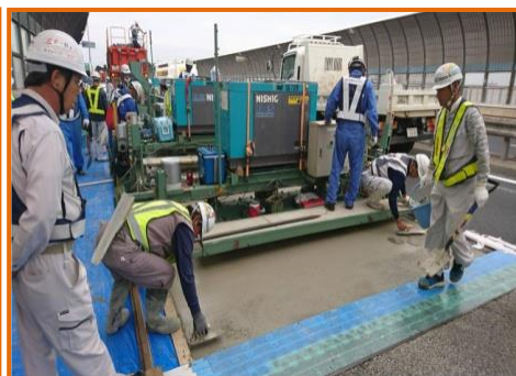
【鋼繊維補強コンクリート打設状況※】
