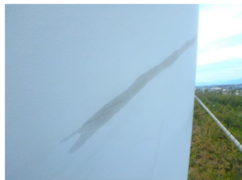
ロープ高所作業詳細撮影写真
