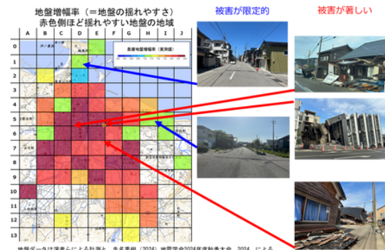
輪島市街にて家は揺れやすい地盤（赤色）で被害が大きい ※横山ほか、2025（地盤工学会より）
