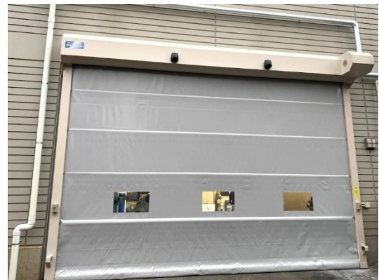
熱を通しにくい素材かつ利便性を担保した 高速シートシャッター設置事例
