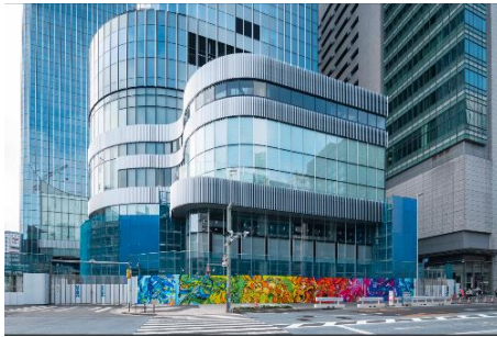
▲日本橋一丁目中地区第一種市街地再開発事業 新築工事用仮囲い ナカミツキ氏による作品
