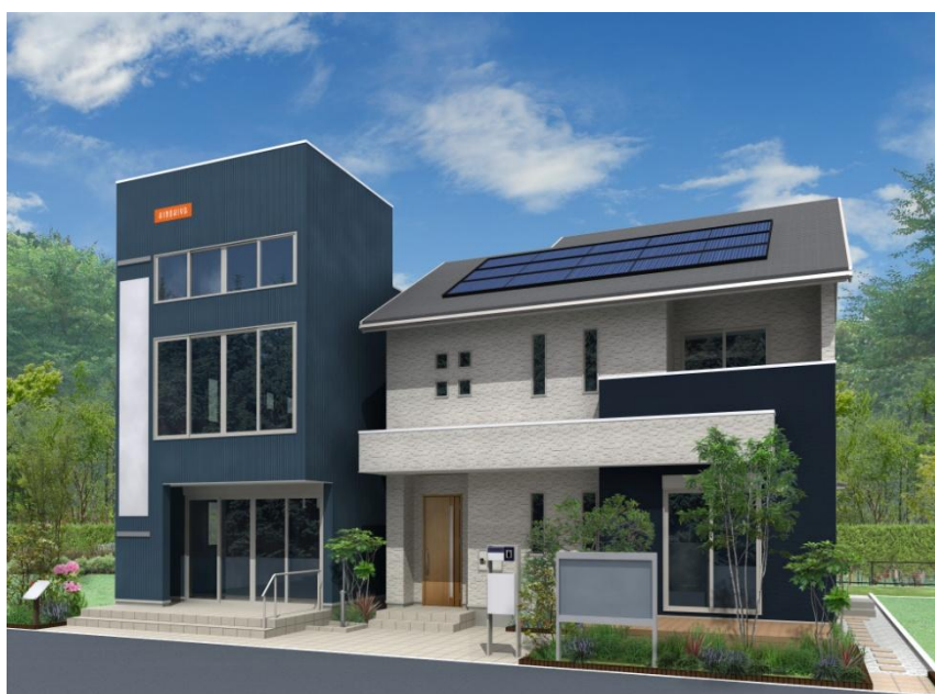
Z空調搭載、30.5坪の超リアル『うしく展示場』 スマート・ワン棟（右）とショールーム棟（左）外観イメージパース。
