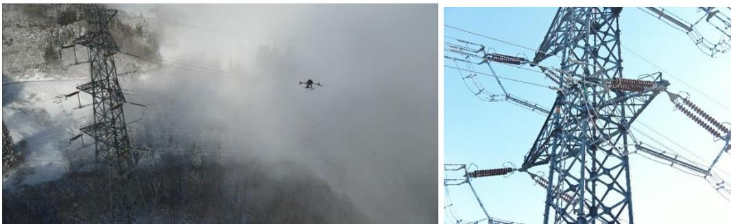
両社はこれまでも飛行ルートおよび撮影アクションを自動生成し、ドローンを活用した送電設備自動点検に特化した技術を確認してまいりました。（<https://www.sensyn-robotics.com/news/chuden-pg>）このたび送電線（架空地線・電力線）自動追尾機能を追加したことで、自動点検飛行中の機体やカメラ操作が不要となり、ドローンに関する特別な知識を持たない作業員でもより簡単に送電線点検業務を実施することが可能になります。
