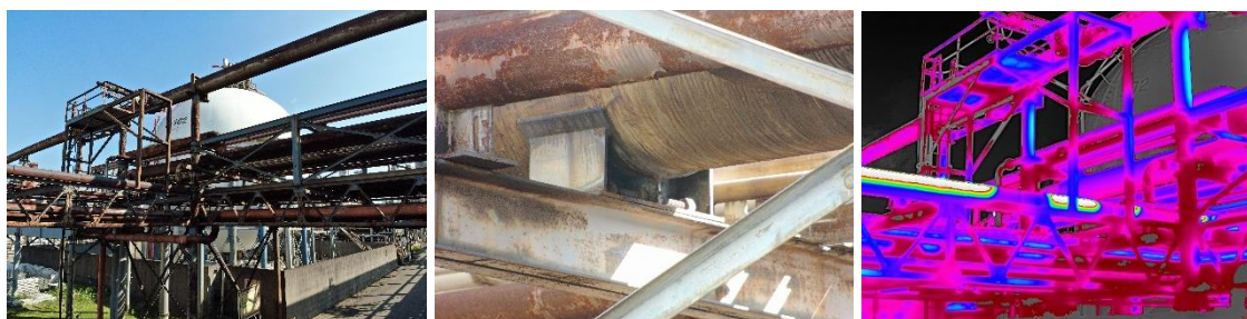
配管奥部まで確認が可能。また、サーマルカメラを用いることで配管の劣化箇所の特定もできる。
