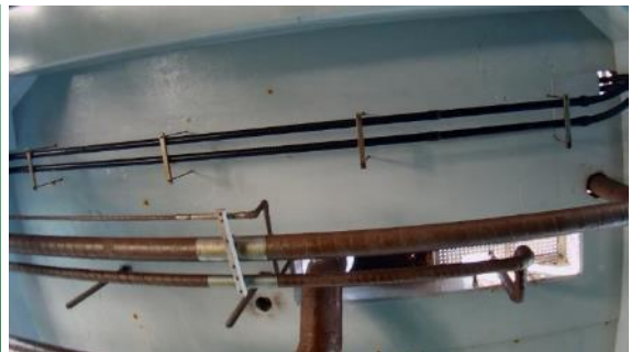
水中ドローンでの栈橋点検
