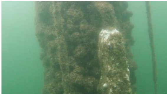
水中ドローンでの栈橋点検
