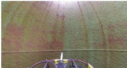
壁面の凹凸、変状を確認
