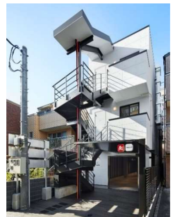
▲「クラウドキッチン」施設外観
