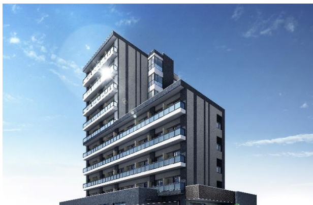
【外観】徳島大学提携国際交流寮アズール
