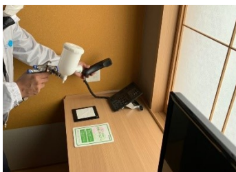
客室の施工(イメージ)
