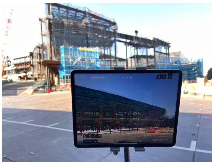
<DataMesh Directorで構築したXRコンテンツを実際の建造物に重ね合わせ、進捗確認をする様子※4>
