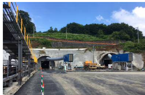
2018年6月時点工事現場イメージ
