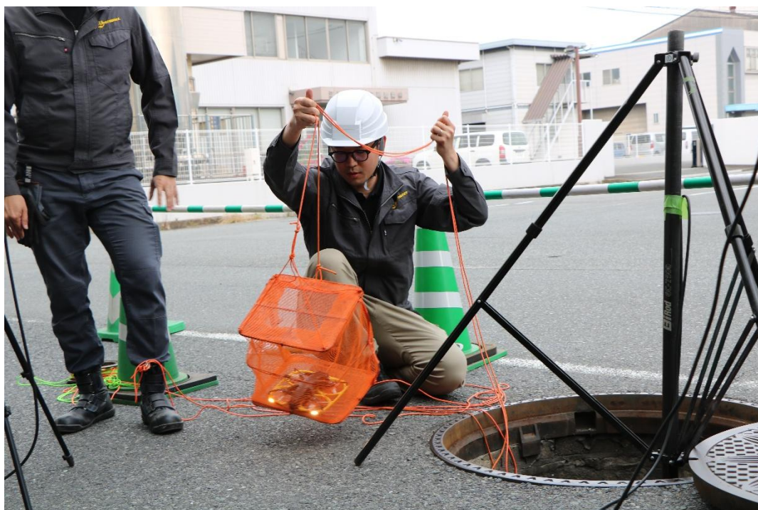
〈下水道管に IBIS2 を進入させる様子〉
