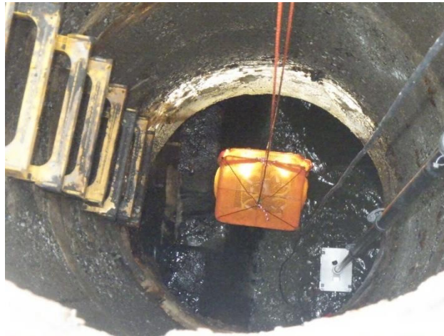
下水道管に「IBIS2」を導入させる様子
