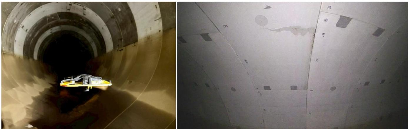
認定事業を通じ、大口径雨水管での IBIS2 飛行と新型距離計測機器の検証を実施。従来手法と比べて点検精度・効率が飛躍的に向上し、市からも有効との評価を得ました。
