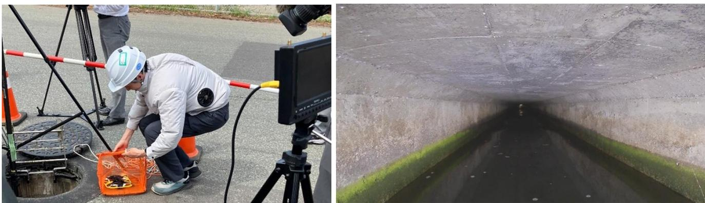
敷設後約 50 年が経過した下水道管で実施。全体のうち約 300m は 1 度の飛行で調査完了。従来の調査に伴うリスクを大幅に軽減し、安全・効率的な点検手法として実証されました。
