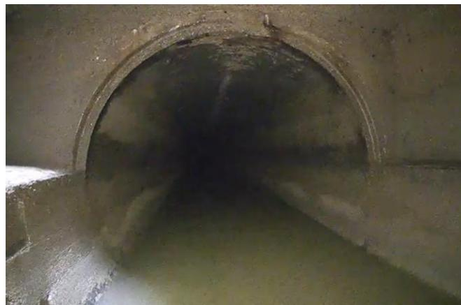
老朽化が進む直径2m以上の下水道管（約54km）を対象とし、踏み入れ困難な環境にIBIS2を投入。飛行による動画収集で腐食やクラックの有無を安全かつ効率的に確認した事例です。
