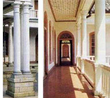
基壇、礎石、円柱、エンタブレチュアの構成は 古代ギリシャ・ローマの神殿に由来するもの
