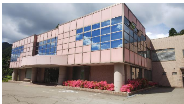
本実証を行う入広瀬診療所の外観
