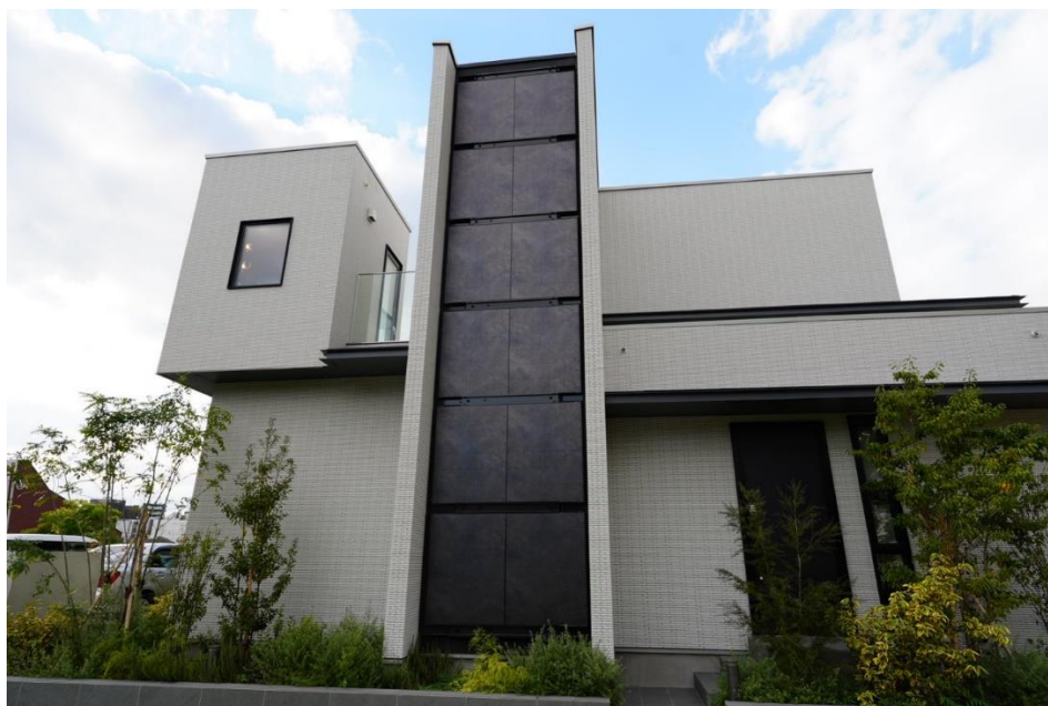
住友不動産ハウジング様住宅展示場での垂直面の太陽光発電パネル向け施工事例
