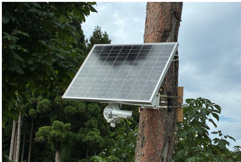
ソーラー給電型汎用カメラの設置
