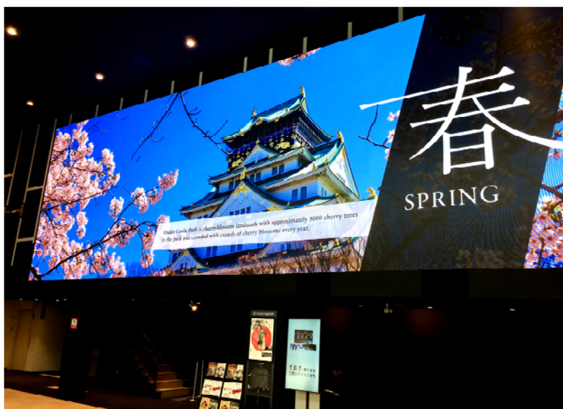
TTホール設置の横 15,360mm 縦 4,352mm の大型 LED ビジョン
