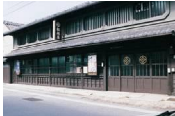
明治 36 年築 旧松坂屋京都業務部建物
