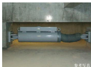
免震ダンパー
