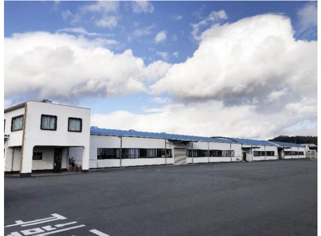
大洋精機株式会社 本社(兵庫県加西市)
