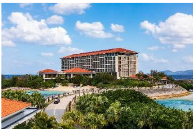
▲沖縄本島と橋で繋がる瀬良垣島のザ・アイランド棟
