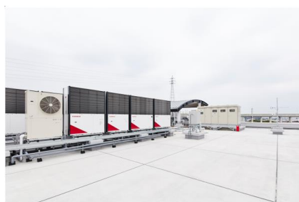
<ハイブリット型 GHP 空調機>
