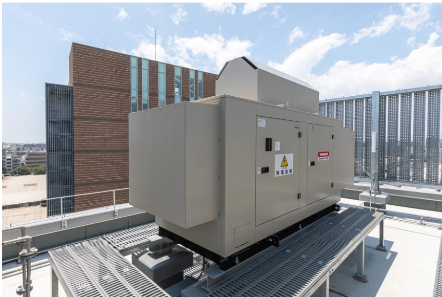
<ヤンマーの「CSセンター(仮称)」に設置した非常用発電機>
