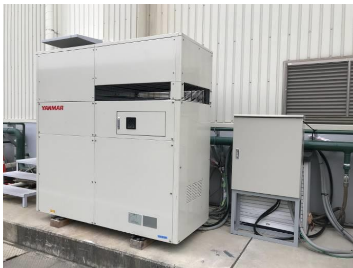
<実証試験で使用した発電機(左)と自動制御モジュール(右)>
