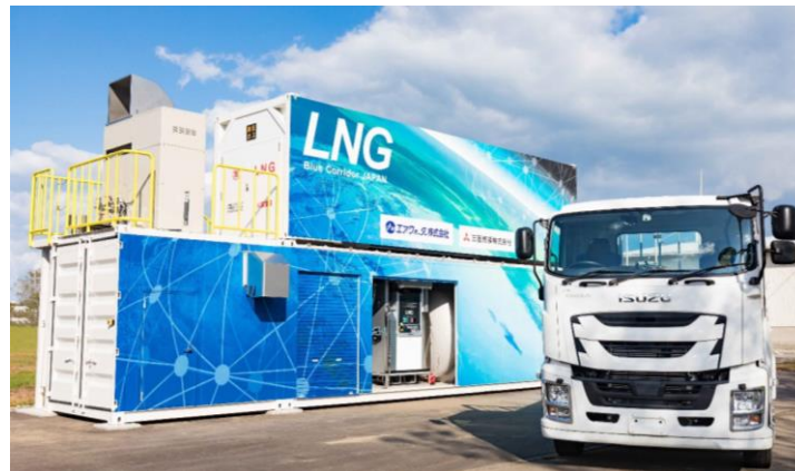
<小型LNG充填設備とLNGトラック>
