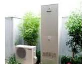
空気熱と電気でお湯を沸かすヒートポンプ給湯機
