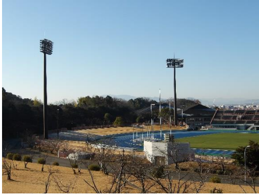
〈第1ゲート、第3ゲート照明塔〉
