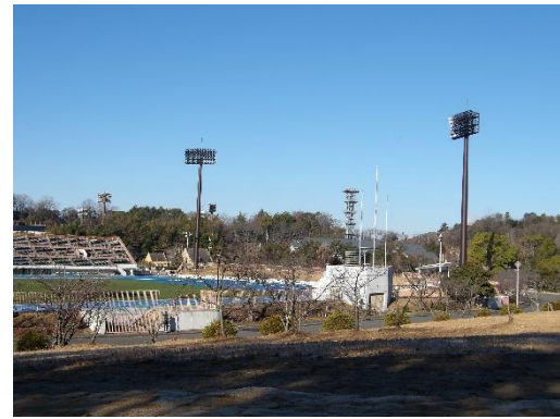
〈第2ゲート、第4ゲート照明塔〉
