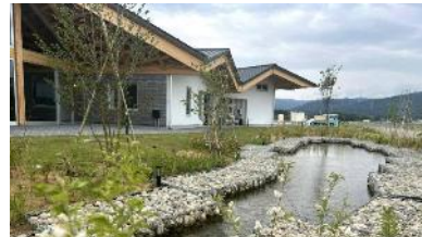
建物と自然を結び付ける 「ビオトープ」
