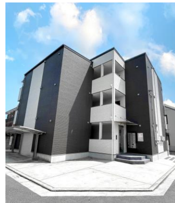
実際に竣工した「Z-MAISON」外観
