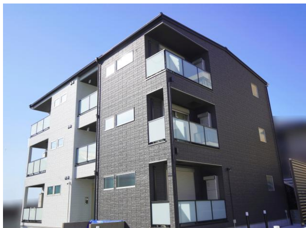
<完成見学会を実施する物件外観>
