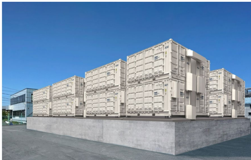
「サーラ浜松蓄電所」系統用蓄電池(コンテナ型NAS®電池)設置イメージ図
