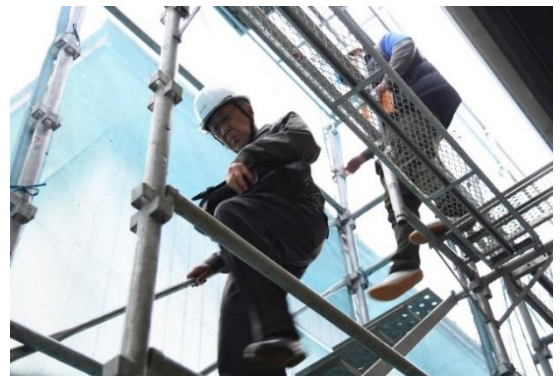
現場をまわり安全指導のため足場に登る
