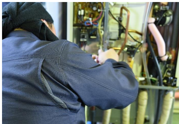
エコキュート設置作業を行う様子
