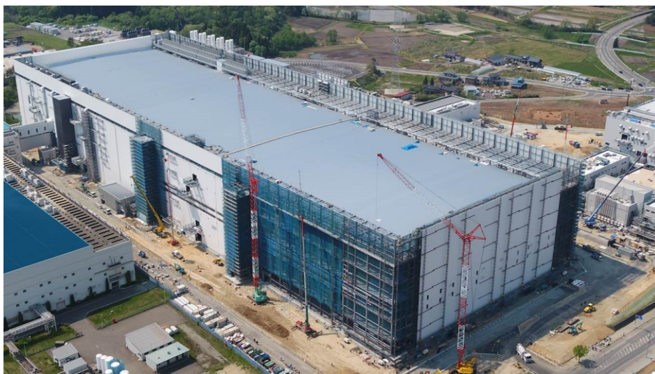
北上工場 第1製造棟（建設中）
