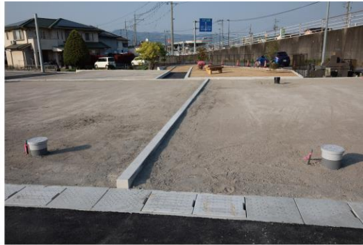
宅地境界コンクリートから
