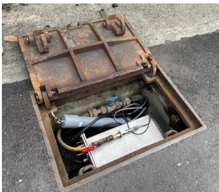
記録計室に設置した水圧監視装置
