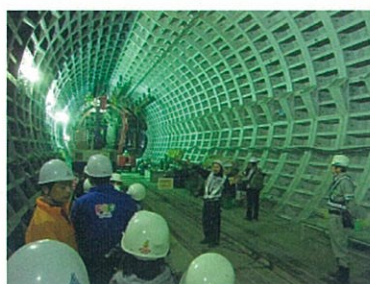
シールドトンネルの工事現場
