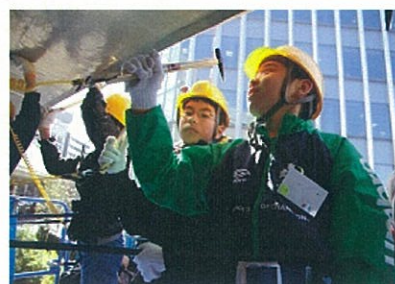
橋梁点検デモ
