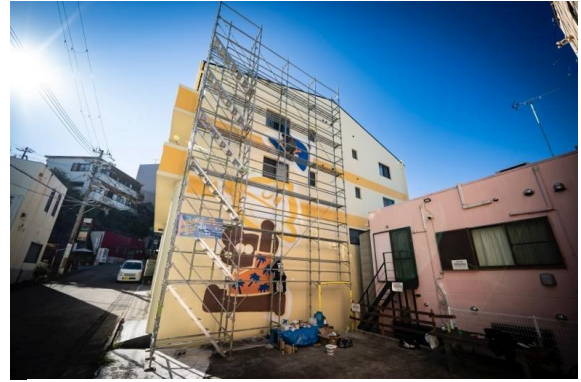
建物は 3 階建てで足場の高さは 10m 以上。恐る恐る作業をする高所恐怖症の 2 人の様子
