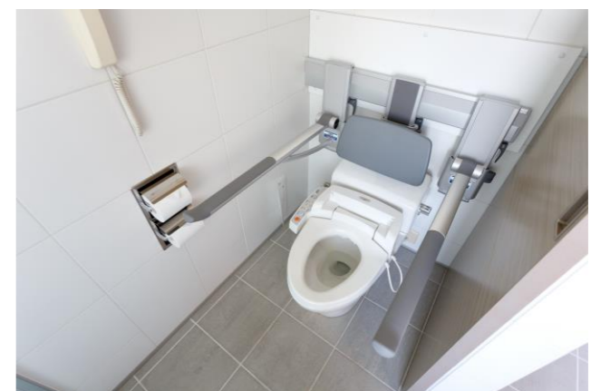
トイレ用手すり・背もたれ (便座カバーを外した状態で撮影)
