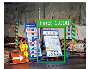
万能塀・フェンス・看板の倒れ検知
