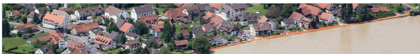
設置区間の空撮。河川沿いの市街地をBEAVER® Damで防護した事例
