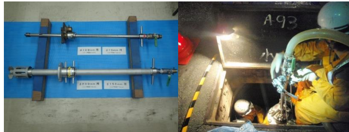
錆取り器と錆取り器挿入時の様子
