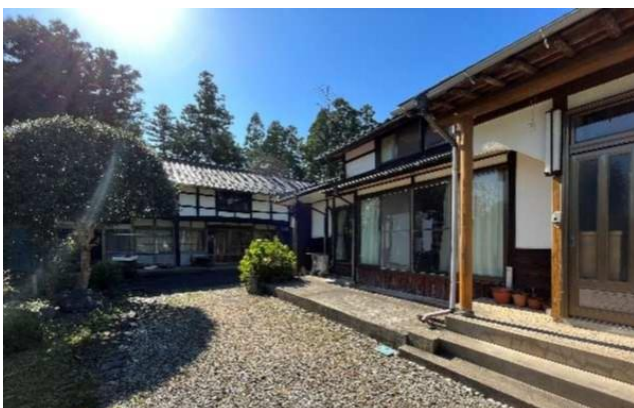
施設外観(改修前)
